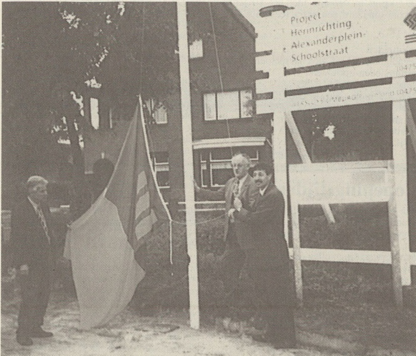
Officiële start werkzaamheden aanpassingen centrum.
